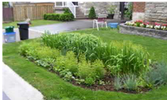
Boulevard Bioretention (Mississauga, ON)
